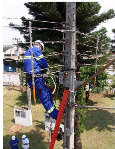
**Nota:** A transposição ilustrada acima, com a baixa tensão desligada e aterrada, poderia ser executada com a mesma energizada, com utilização de lençóis isolantes em ambos os lados da estrutura. É obrigatório o desligamento e aterramento da BT para as estruturas S1, em que o profissional esteja escalando do mesmo lado da rede.
