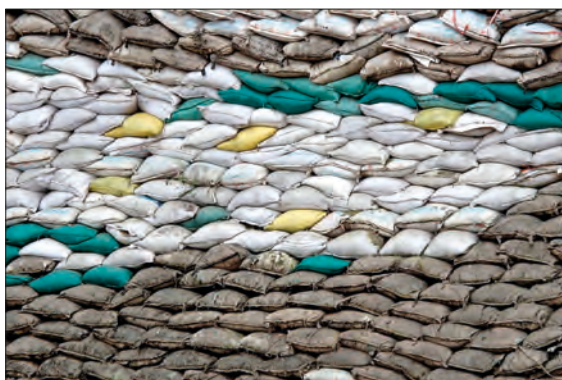
Imagen 22. Dique de sacos colocados a tizón
