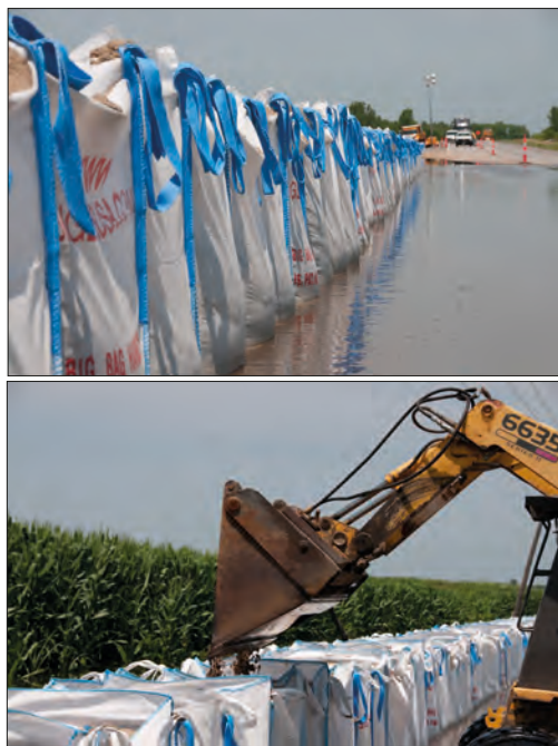
Imagen 31. Construcción de diques con sacos de escombros
