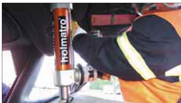
Imagen 277. Colocación de cilindro de separación
