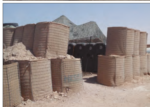
Imagen 27. Construcción de dique con gaviones modulares
