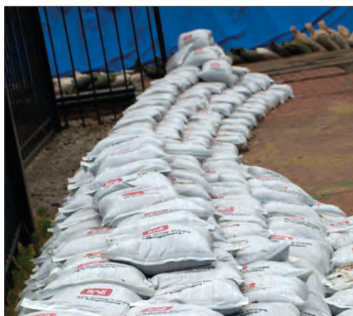
Imagen 21. Dique de sacos colocados a sogá o de forma piramidal
