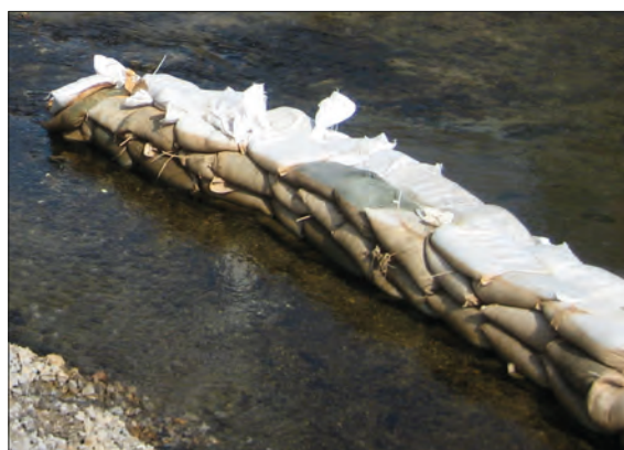
Imagen 24. Base del dique colocado a tizón
